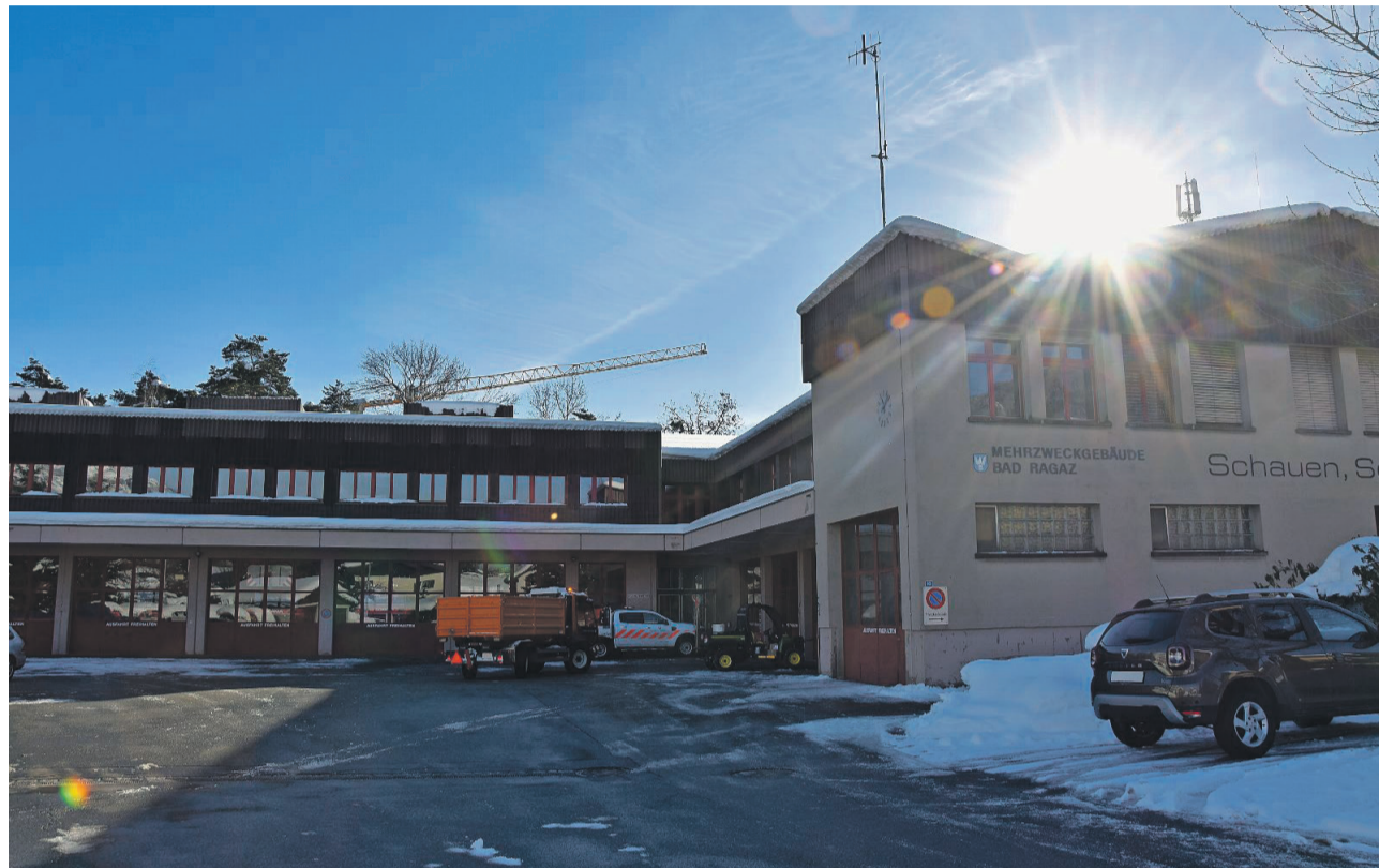
Ungewisse Zukunft: Feuerwehr und Werkhof sollen umgesiedelt, das Mehrzweckgebäude anderweitig genutzt werden.
